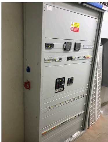
Obrázek.: hlavní rozvaděč v suterénu budovy T, detail rezervního jističe pro napájení automatické brány a napájení 230 AC pro turniket
